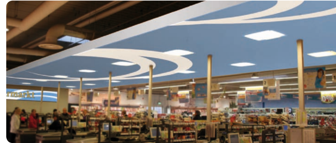
SYSTEM-Decke mit Kabelschächten zur Versorgung der einzelnen Kassen
